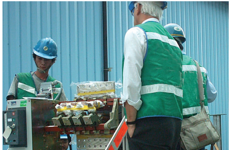
Feld-Kurzschlussprüfungen mit einer auf einem Wagen installierten Kurzschlussvorrichtung
