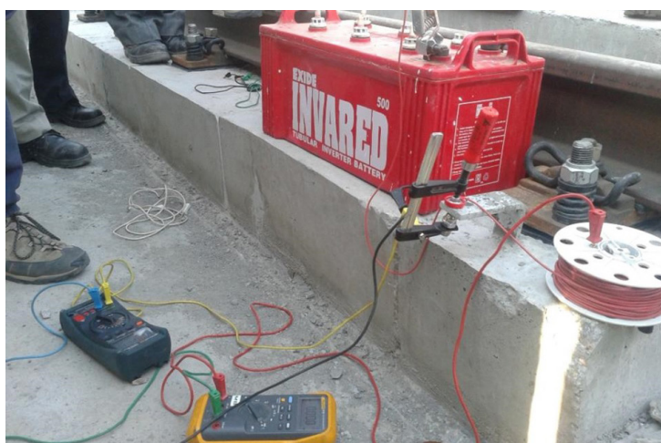
Medición de corriente de fuga
