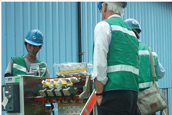
Essai de court-circuit sur site à l'aide d'un dispositif de court-circuit installé sur un chariot
