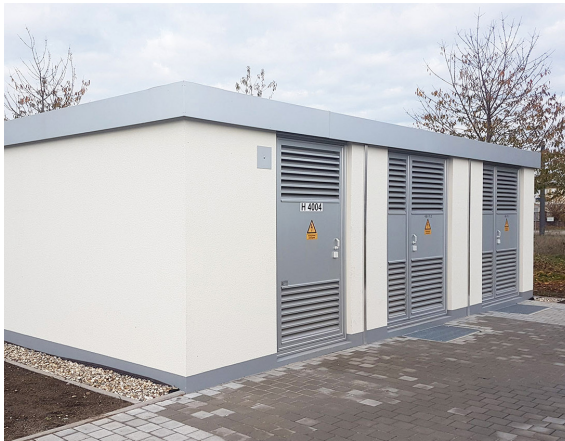
Envoltente de hormigón
