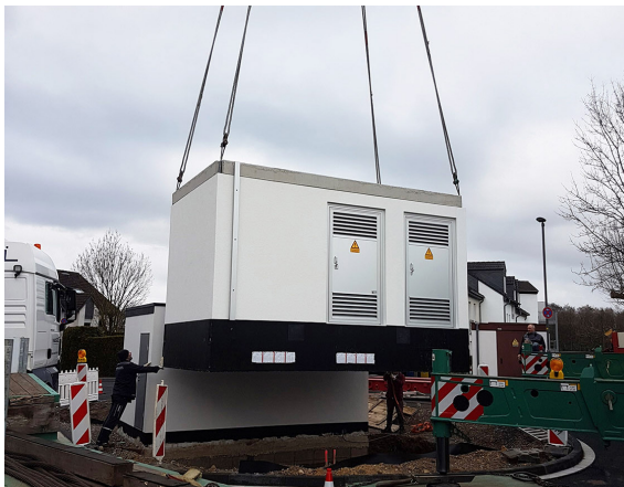
Traslado de un envoltente
